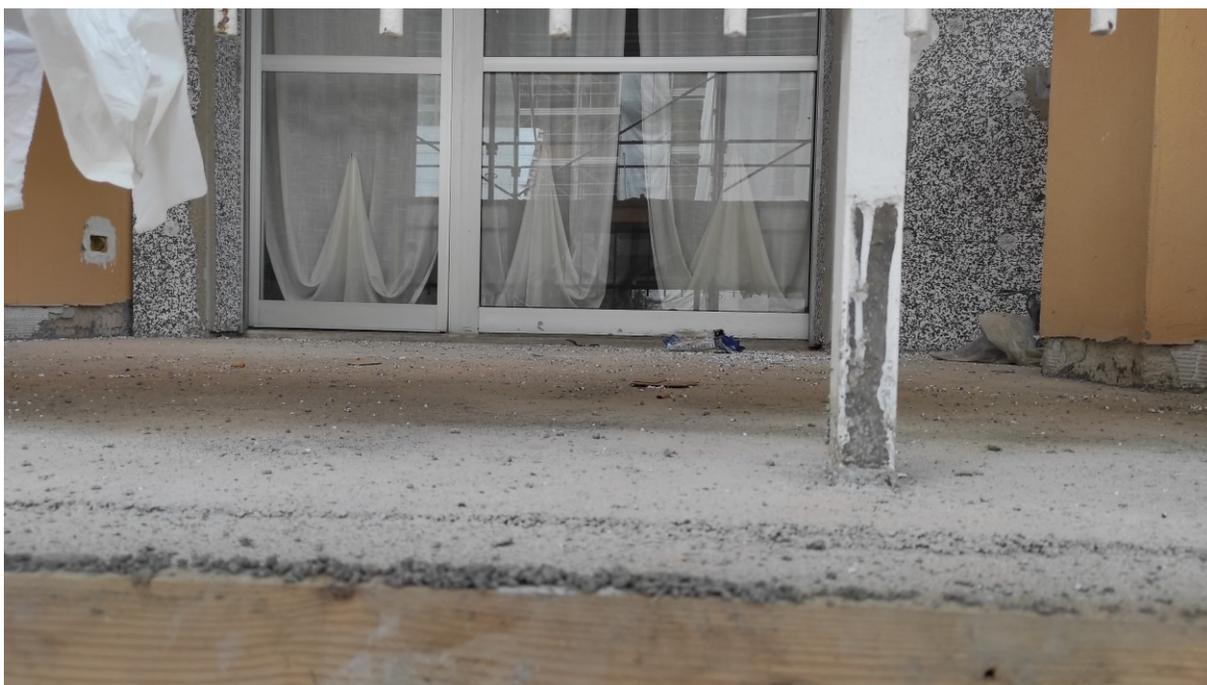
Alla terminazione del massetto è visibile l'alloggiamento del profilo gocciolatoio; i
