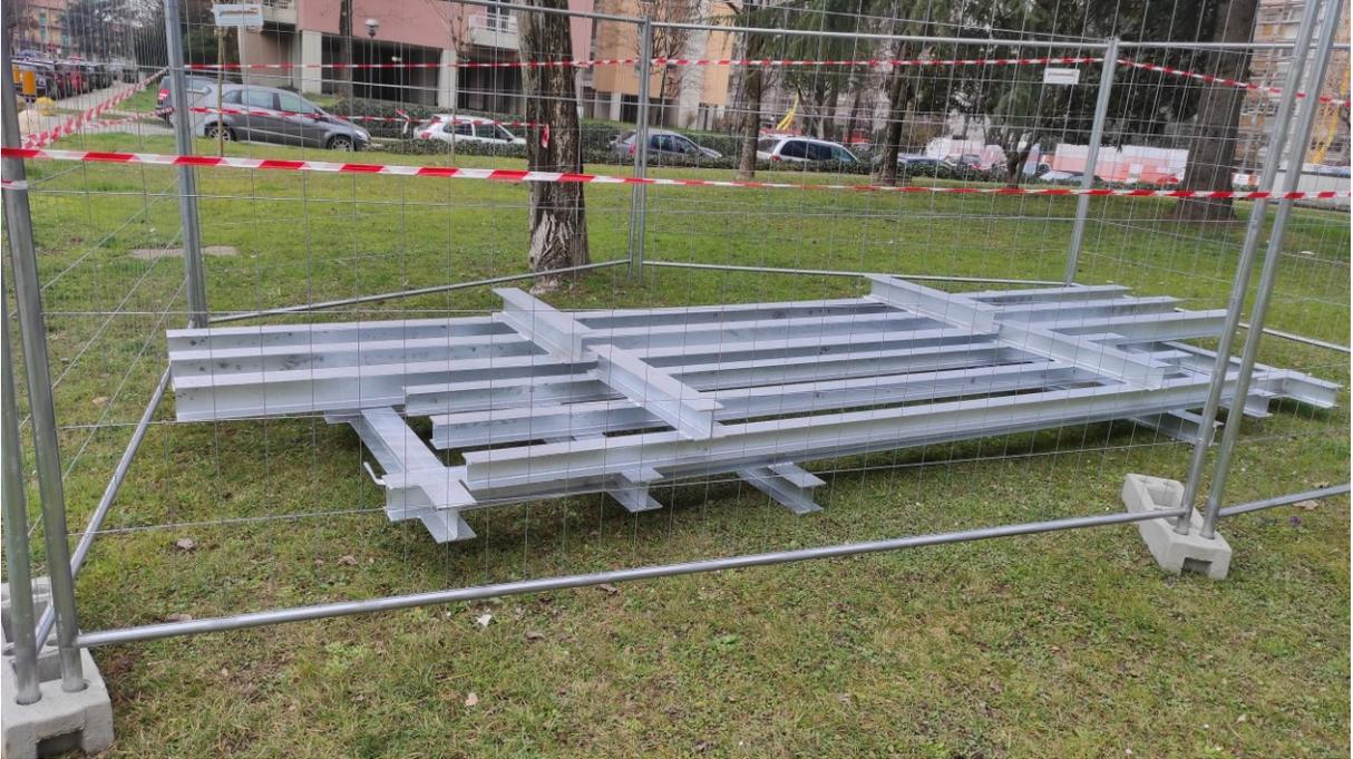
Sono stati rimossi gli angolari di ferro dei balconi e depositati in area di cantiere in attesa di smaltimento. Si effettua pulizia dei balconi a seguito di rimozione pannelli con amianto.
